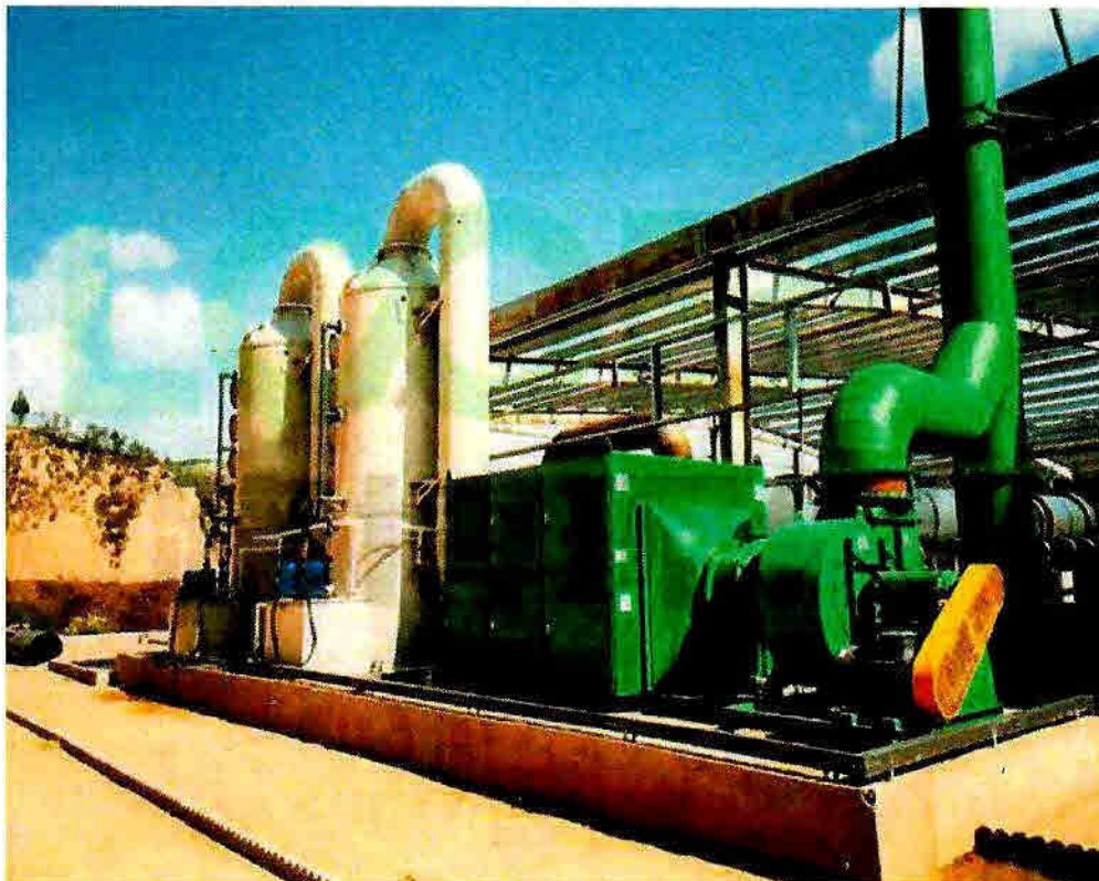
Фиг.2. Вид на комбинираната система за двустепенно разпръскване на вода плюс адсорбционен модул с активен въглен
